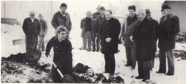
Bürgermeister Kübler beim 1. Spatenstich der Hebsacker Halle am 21. 10. 1978 Aufnahme: Zeitungsverlag Waiblingen
